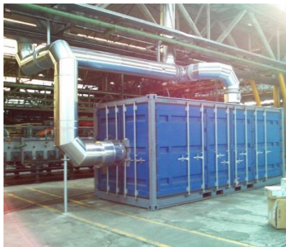
应用场合: 管子制造 处理量: 6000\text{ Nm}^3/\text{h} 处理: 一氧化碳
