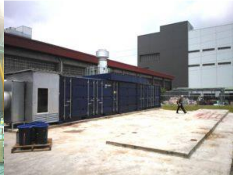
应用场合: 凹版印刷 处理量: 26000\text{ Nm}^3/\text{h} 处理: 乙酸乙酯, 甲苯, 甲乙酮, IPA 与 甲醇
