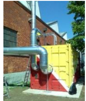
应用场合: 轮胎制造 处理量: 8000\text{ Nm}^3/\text{h} 处理: 庚烷
