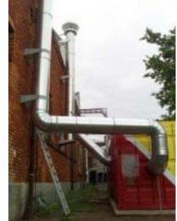
应用场合: 轮胎制造 处理量: 8000\text{ Nm}^3/\text{h} 处理: 庚烷
