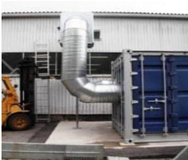
应用场合: 柔版印刷 处理量: 15000\text{ Nm}^3/\text{h} 处理: 乙酸乙酯, 乙醇, 丙酮,
