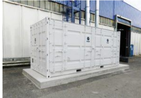
应用场合: 柔版印刷 处理量: 15000\text{ Nm}^3/\text{h} 处理: 乙酸乙酯, 乙醇, 丙酮, 其他
